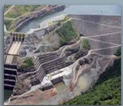
USINA HIDRELÉTRICA DE CAMPOS NOVOS - SC.
